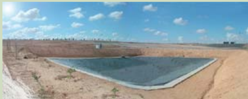
المصب المراقب للفضلات المنزلية بعقارب - صفاقس حوض تجميع العصارة، العزل بغشاء صناعي السنة 2003
