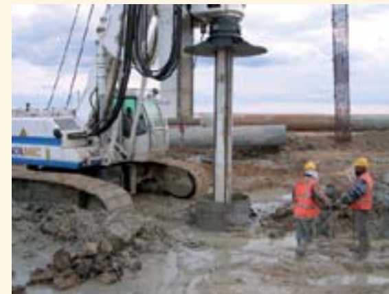
أشغال الاسس العميقة بالمركب السكني والتجاري «سكاى سنتر» بالبحيرة الشمالية بتونس، السنة 2011، عدد الخوازيق 210
