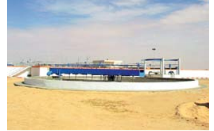
محطة معالجة المياه المستعملة بدوز - قبلي، السنة 2001
