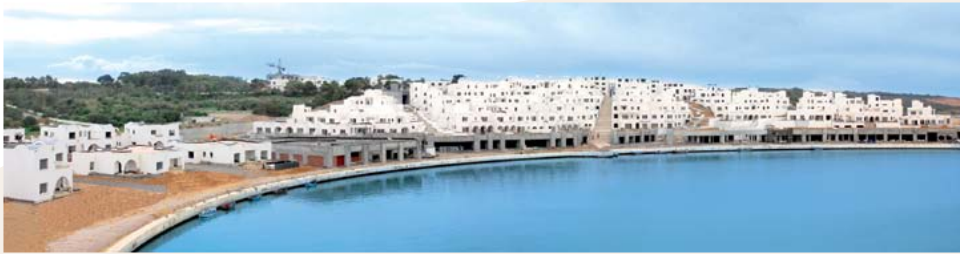
مشروع بناء وحدات سكنية بخليج قمرت، السنة 2011، المساحة 60000 م 2
