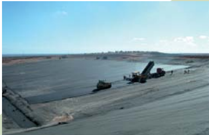
المصب المراقب للفضلات المنزلية بعقارب - صفاقس أشغال عزل أحواض الطمر بالخرسانة الإسفلتية، السنة 2003
