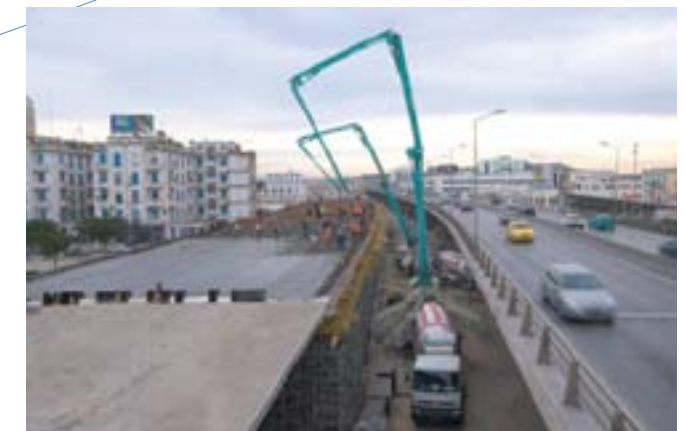
Echangeur Z4 à l'Avenue de la République à Tunis Travaux d'exécution du tablier en béton précontraint
