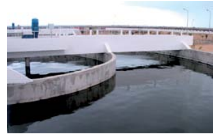
محطة معالجة المياه المستعملة لصفاقس الشمالية بسيدي منصور، قنال الأكسدة، السنة 2002
