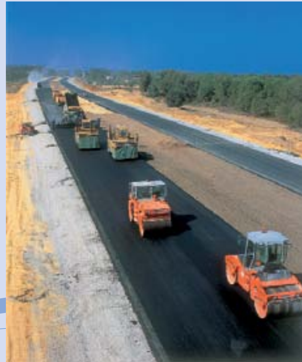
الطريق السيارة «تونس - بنزرت» أشغال فرش الخرسانة الاسفلتية، السنة 1999 Autoroute Tunis - Bizerte Travaux de mise en place du béton bitumineux, année 1999 Highway Tunis - Bizerte Work of installation of the bituminous concrete, year 1999
