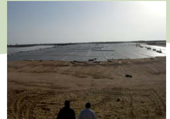
المصب المراقب للفضلات المنزلية بمدنين العزل بغشاء صناعي، السنة 2005
