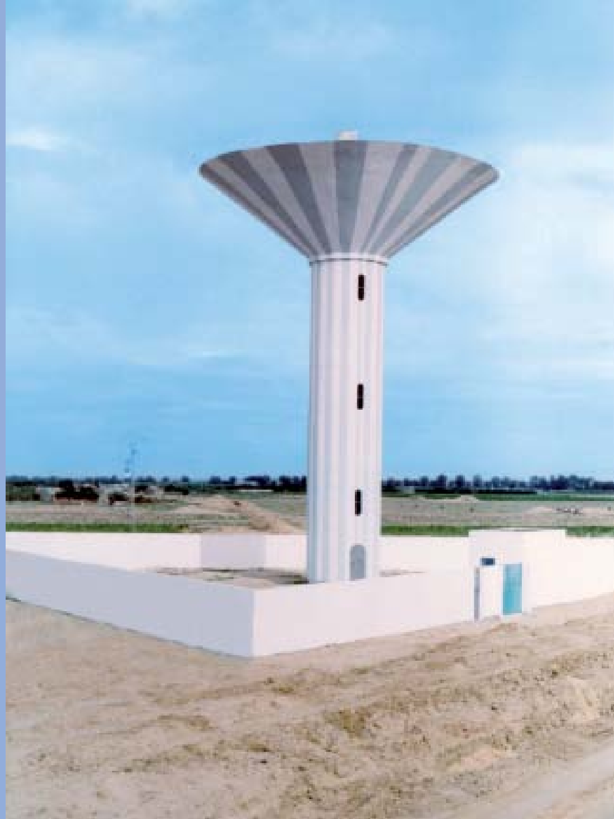
خزان للماء الصالح للشرب بقرادة بالقرون، السنة 2003، الارتفاع 23 متر Réservoir d'eau potable à Rakada - Kairouan, année 2003, hauteur 23 m Drinking water tank in Rakada - Kairouan, year 2003, height 23 m
