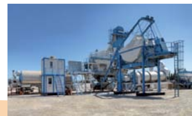
الورشة - مركزية لصناعة الخرسانة الاسفلتية Parc du matériel - Centrale à enrobé Equipment park - Bituminous mix plant
