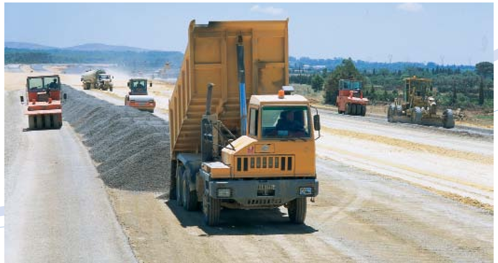
الطريق السيارة «تونس - مجاز الباب», أشغال مختلف الطبقات, السنة 2002 Autoroute Tunis - Medjez El Bab, travaux du corps de chaussée, année 2002 Tunis - Medjez El Bab highway, pavement works, year 2002
