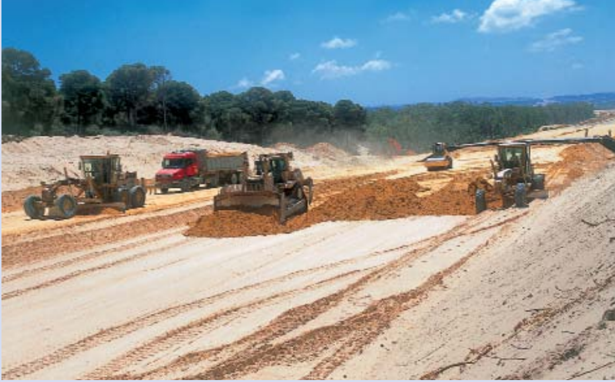
الطريق السيارة «تونس - بنزرت» - أشغال التمهيد والتسوية، السنة 1999 Autoroute Tunis - Bizerte - Travaux de terrassement, année 1999 Highway Tunis - Bizerte - Earthworks, year 1999
